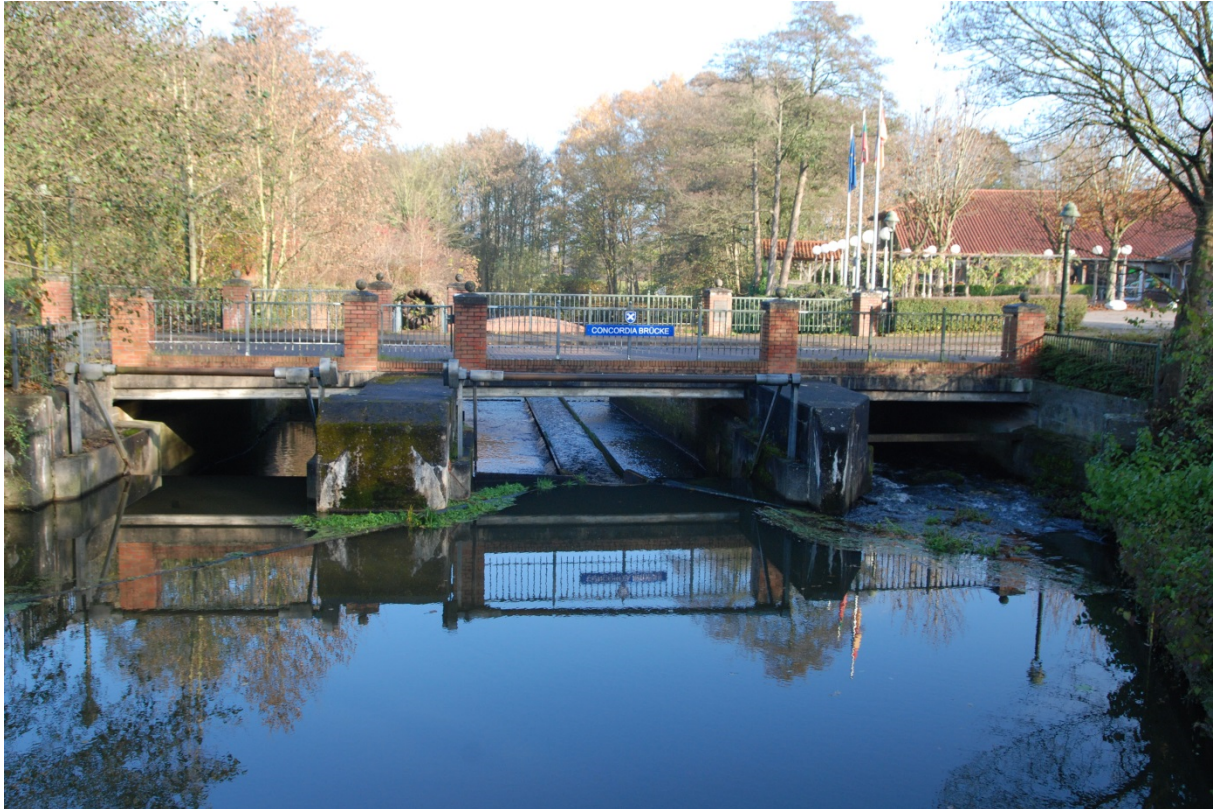
Abbildung 6: Blick flussabwärts auf das Mühlenwehr unter der Concordiabücke mit Bootsrampe (Mitte) und Fischtreppe (rechts)
