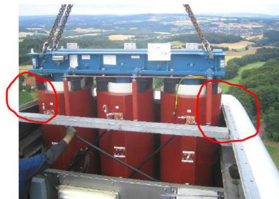
Abbildung 18-1: Führen des Transformators in das Maschinenhaus
