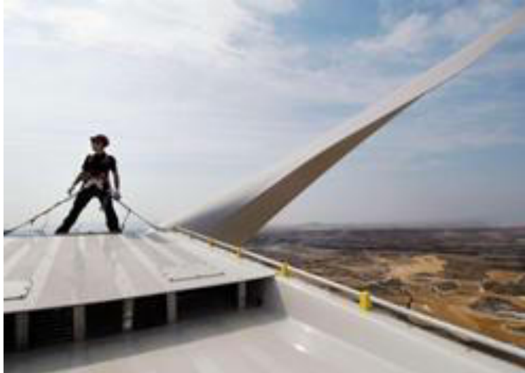
Abbildung 10-2: Arbeiten auf dem Maschinenhaus
