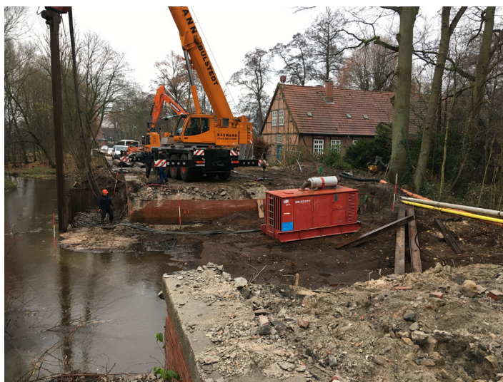
K212, abgerissene Straßenbrücke über die Wümme
