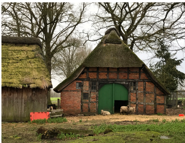
Wohnwirtschaftsgebäude mit Scheune/Stall in Hatzte am 19.02.2020.
