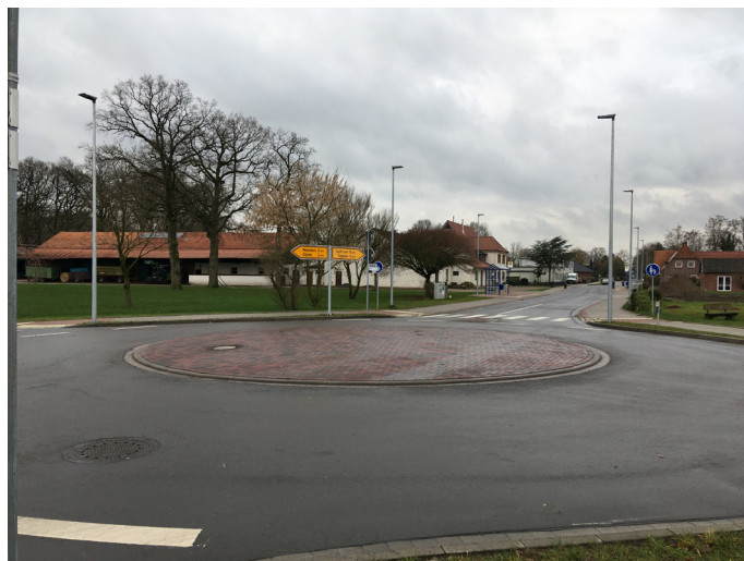
K 201 Ortsdurchfahrt Horstedt nach Ausbau
