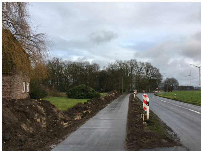
Radweg an der K 120 von Wense nach Viehbrock im Bau (Dezember 2020)
