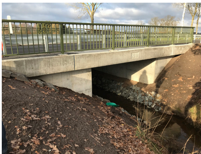
K 219 Brücke über den Westerholzer Kanal
