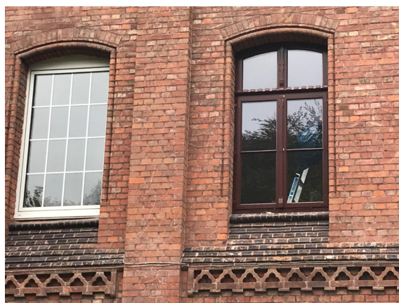
Fensterrekonstruktion am Ulrich'schen Wohnhaus, Mühlenstraße 43 in Scheeßel am 09.09.2020.
