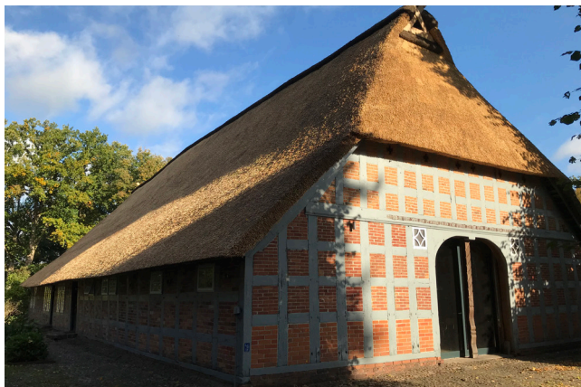
Erneueres Reetdach am Wohnwirtschaftsgebäude in Hellwege, Dorfstraße 13 am 22.10.2020.
