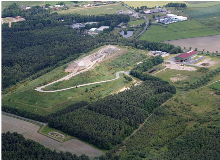
Entsorgungsanlage in Helvesiek
