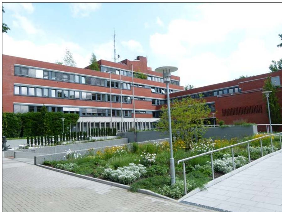
Neugestaltete Außenanlagen Kreishaus Rotenburg
