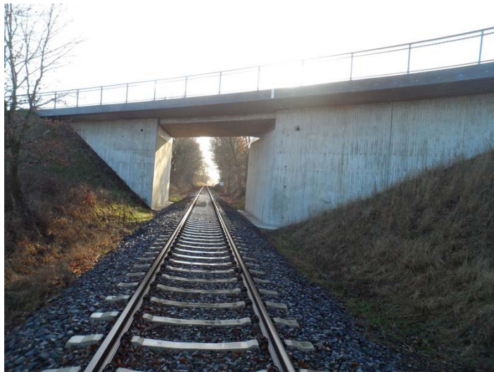
Brücke im Zuge der Ortskernentlastungsstraße Minstedt (K 102)
