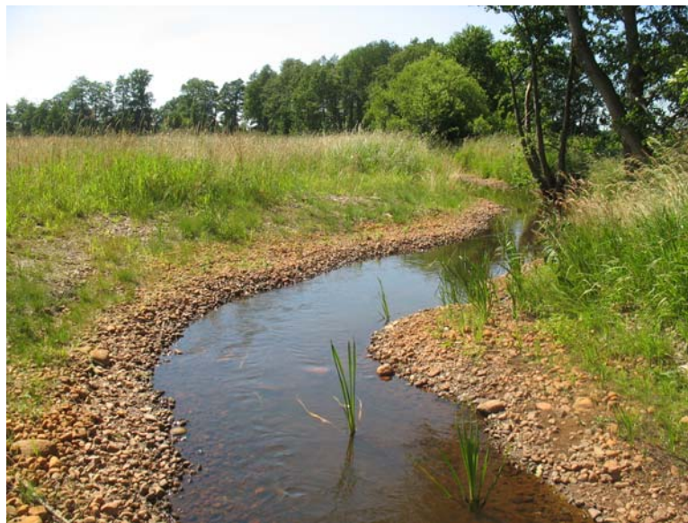
Eingebaute Kiesbetten im Lünzener Bruchbach
