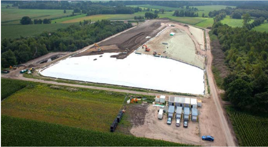
Die Deponie Kuhstedt von oben während der Baumaßnahme (Quelle: HEILIT)
