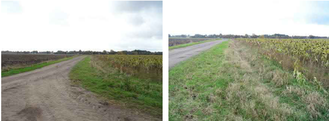
Abb. 5: betroffene Entwässerungsmulde im Abbiegebereich Westerbeck/landwirtschaftlicher Weg
