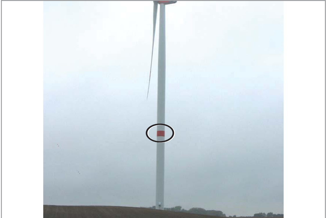
Abb. 5: Roter Farbring an Anlage mit Gesamthöhe >150 m
