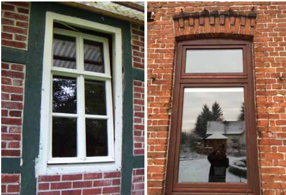
Beispiel für erneuertes Sprossenfenster und Fenster ohne Sprossenteilung
