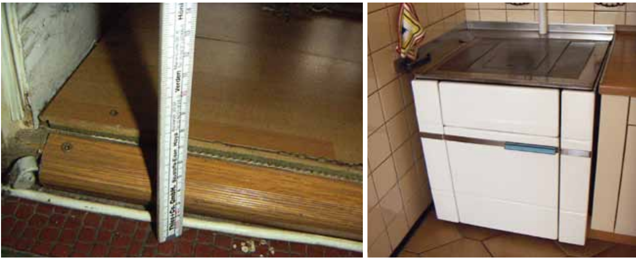
Abschätzung der vorhandenen Fußbodendämmung und Küchenofen in Betrieb
